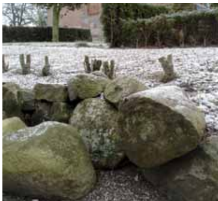
Tjørnehækken skal fornyes, og diget repareres.
