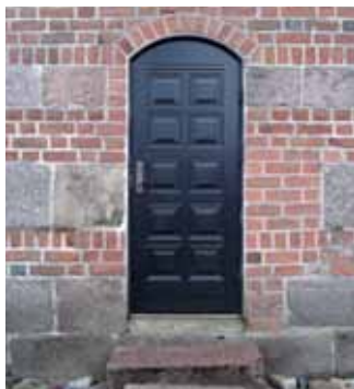
Den lille dør på nordsiden er repareret.
